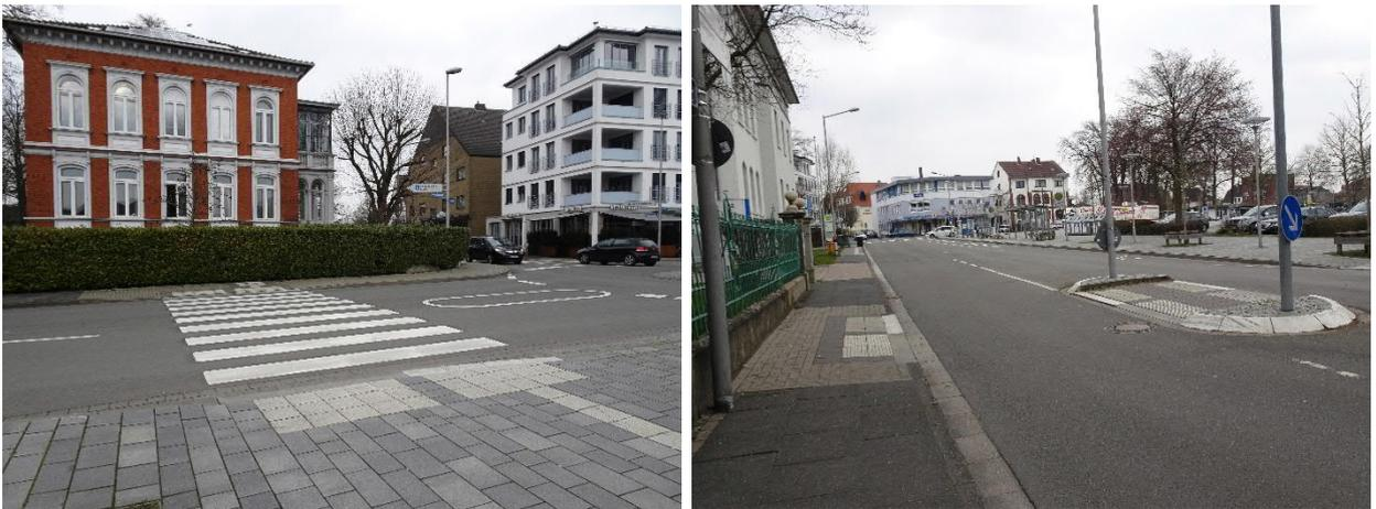
Abb. 15 Differenzierte Bordhöhe mit Nullabsenkung und 3 cm Bord (Beispiel Stadt Bünde)
