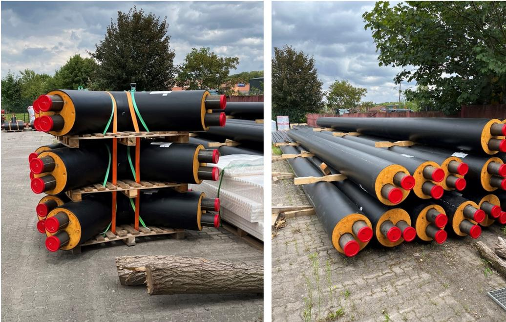
**Abb. 2:** Die Fernwärmerohre für die Hauptstraße liegen auf dem städtischen Bauhof zum Einbau bereit (Fotos: Manfred Priebisch, Vereinigte Stadtwerke)
